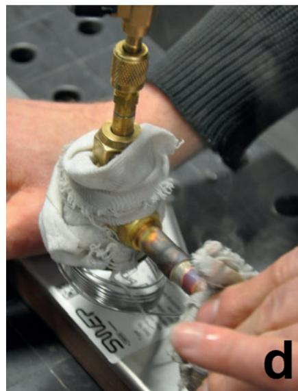
▲ Bild 12. Lotring und Expansionsventilgehäuse werden aufgesteckt (a), der Formiergasanschluss wird in die Gegenseite des Gehäuses gesteckt und zum Schutz mit einem nassen Lappen umwickelt (b), dann wird mit dem „Hookyduktor“ gelötet (c) und zum Schluss mit einem weiteren nassen Lappen abgeschreckt (d)
