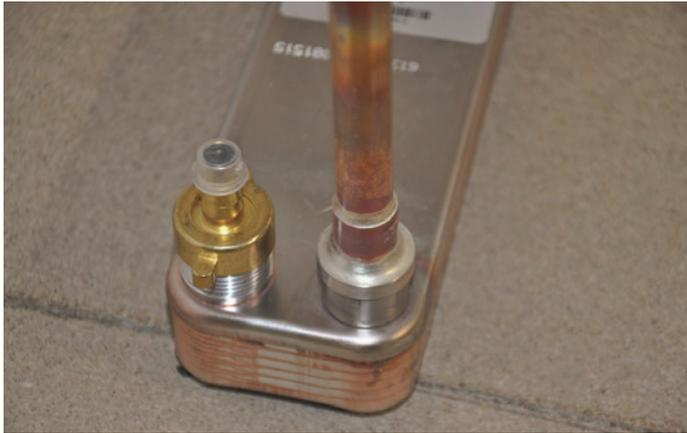
◀ Bild 10. Fertige Lötstelle zwischen Chromnickelstahl-Anschlussstutzen des Plattenwärmetauschers und einem Kupfer-Absatznippel
