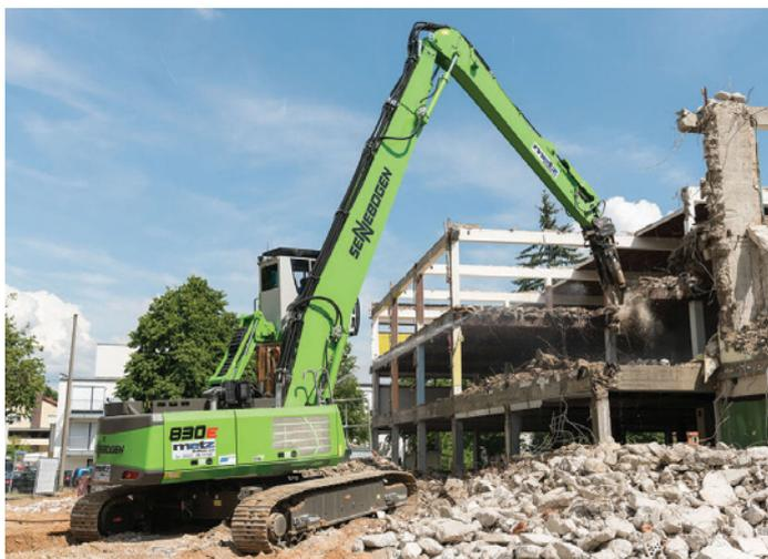
◀ Bild 1. In so einen Abbruchbagger „830E“ der Marke Sennebogen kommen die Zylinder zum Einsatz, deren Schweißvorgang in dieser Reportage beschrieben wird.
