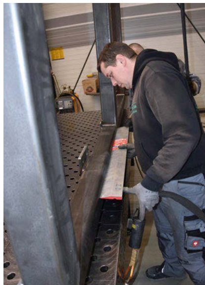
▲ Bild 10. Auch dieses große Bauteil wurde durch Tiefeninduktion ohne Dehnungsbehinderung werkstoffschonend gerichtet.
