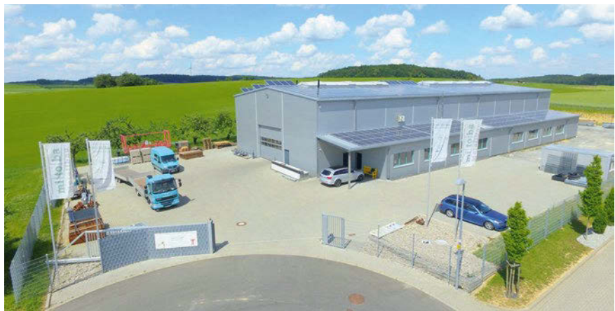
▲ Bild 2. Das Firmengebäude von Mitoba Metallbau in Assamstadt
